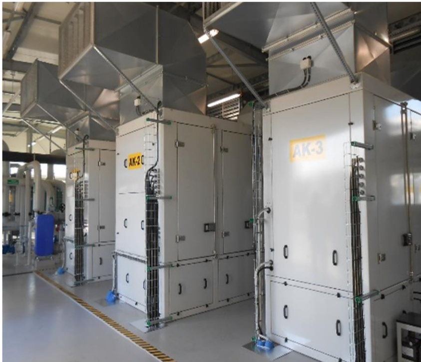
Grupa Azoty SA (2014) 1x MAN E2876 LE302 + 2x MAN E2842 LE322 Gaz postprocesowy (85-95% H 2 )
