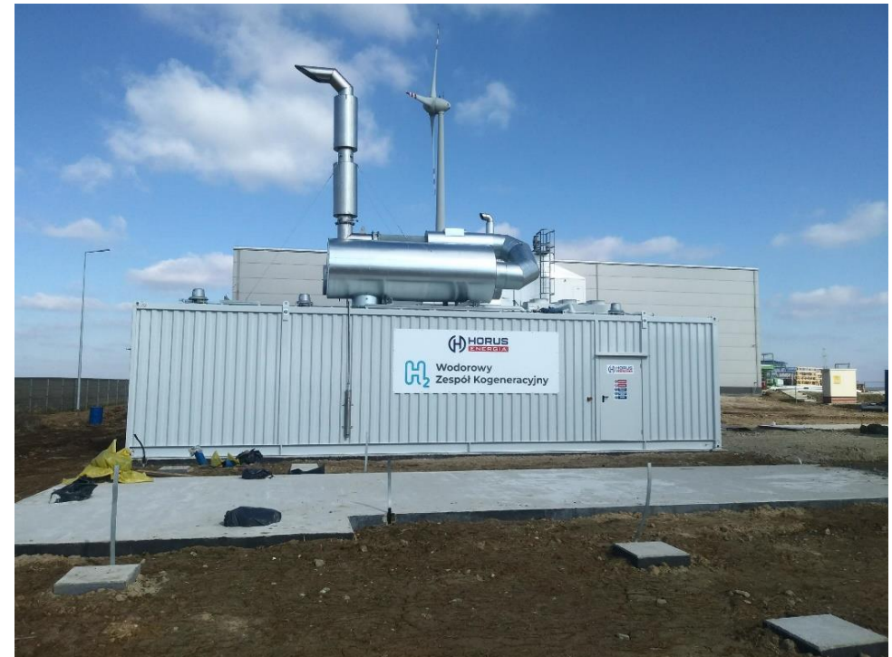
Promet Plast (2022) 1x Perkins 4016-61TRS2 Wodór z elektrolizy (99.999% H 2 )
